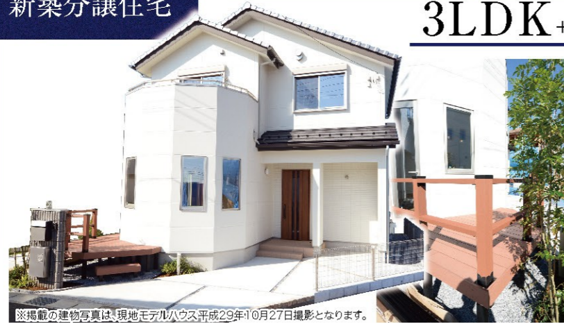
※掲載の建物写真は、現地モデルハウス平成29年10月27日撮影となります。
