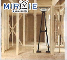
耐震性のみならず、揺れを最大70%制御する住友ゴム製震ダンパー「ミライエ」を標準装備した、耐震+制震のダブル工法。熊本地震でもありました震度7を2回、その後震度7を超える余震にも効果を発揮しています。
